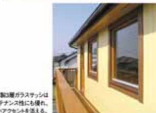
木製3層ガラスサッシはLow-Eガラスを採用し、機能性・メンテナンス性にも優れ、外観に美しいアクセントを与える。
