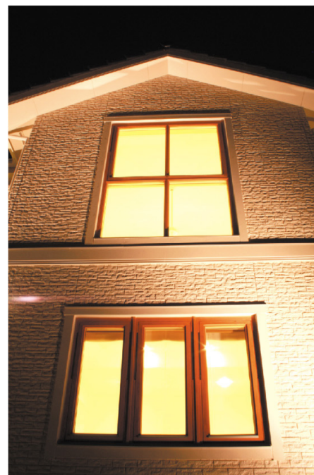
スウェーデン製の木製トリプルガラスサッシ。180度回転する窓は掃除も簡単。メンテナンス性に優れている。
