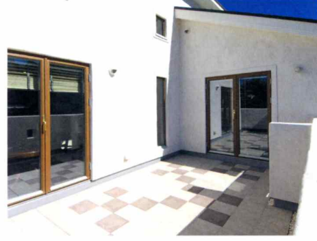
木製フレンチドア（3重サッシ）の広い開口部から、リビングにもダイニングにも出入りできるルーフバルコニーは、開放感に溢れている。
